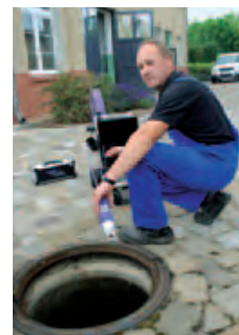
NUWAB-Mitarbeiter Andreas Krüger zeigt, wie die neue Kamera im Kanalnetz eingesetzt wird.
